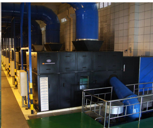
重庆江增机械有限公司 应用于污水处理的曝气鼓风机
